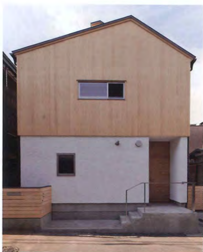
住宅密集地に建つ「高円寺の家」。木造2階延べ19坪。設計は松井郁夫建築設計事務所、施工はキューブワン・ハウジング
