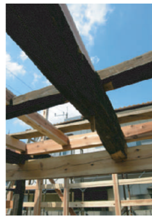
組み上げられた大梁
