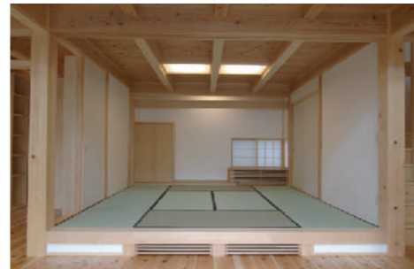
1階和室 段差のスリットからFF暖房の温風が吹く
